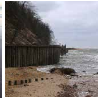
Hangsicherung mit Wellenbrecher
