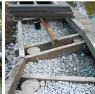
Konstruktion Uferbefestigung
