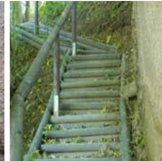
Waldweg mit Stufen und Geländer befestigt
