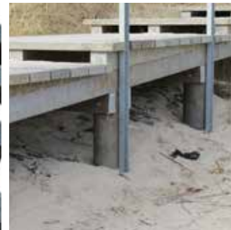
Treppen- und Stufenkonstruktion für Strandzugang
