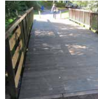
Rad- und Gehwegbrücke
