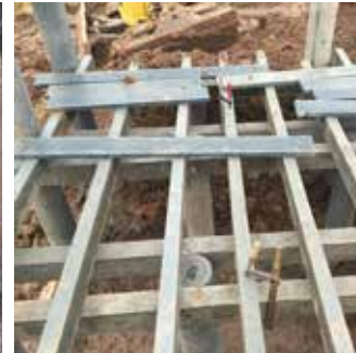
Pfahl-Unterkonstruktion für Aussichtsplattform
