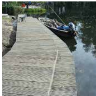
Anlegesteg mit Podest
