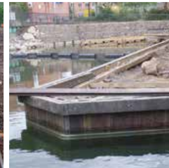
Štetovnice s trecími pásy
