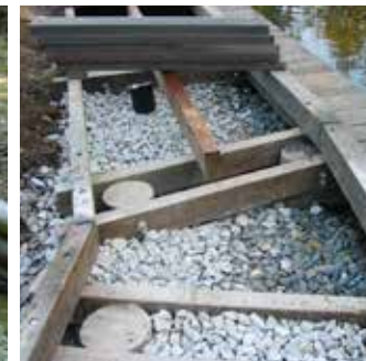
Výstavba bankovní stabilizace
