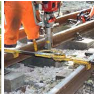
Przykręcania szyn
