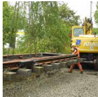
Prefabrykowane odcinki trasy
