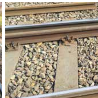
Gleisbett Straßenbahn Berlin
