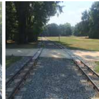
Gleisbett Parkeisenbahn Dresden
