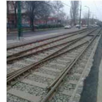
Železniční spínač v Budapešti
