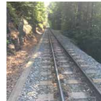
Položené pražce Weißeitztalbahn
