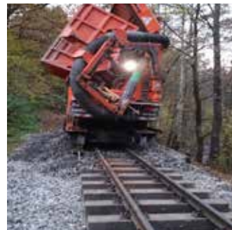
Šterkování železničního lože
