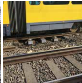
Výměna železničních vleček na tramvajové trati v Berlíně
