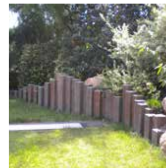
Hotová palisádová stena
