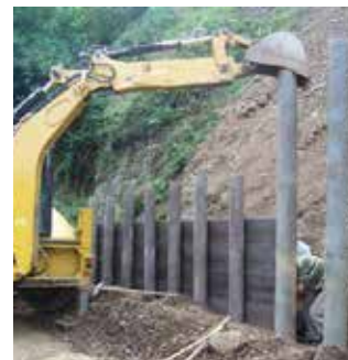
Elementy montażowe ściany ochronnej
