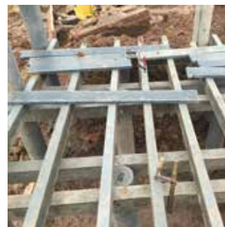
Podkonstrukcja słupowa platformy widokowej
