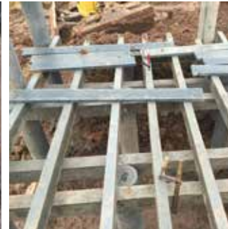
Pfahl-Unterkonstruktion für Aussichtsplattform
