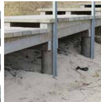
Treppen- und Stufenkonstruktion für Strandzugang
