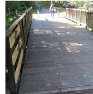
Rad- und Gehwegbrücke
