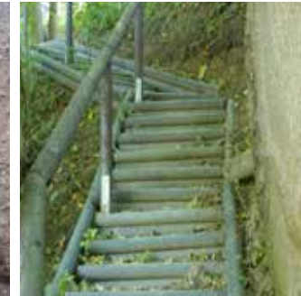
Waldweg mit Stufen und Geländer befestigt
