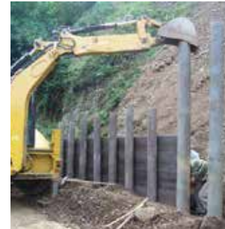
Pilotní hnačí a montážní práce ochranných zdí
